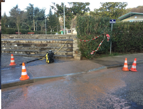
Construction d'un passage bateau en face le cabinet du Docteur ESPAZE afin d'améliorer l'accessibilité
